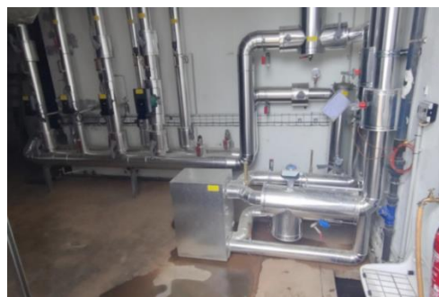
Sous-station après travaux
