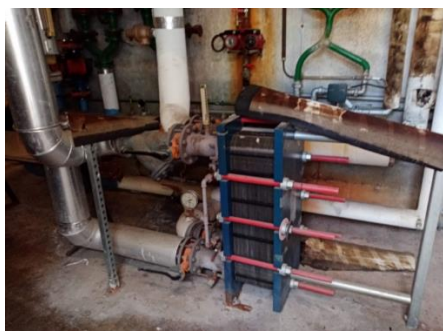
Sous-station avant travaux
